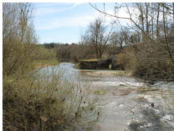
Ouvrage après travaux (Avril 2015)
