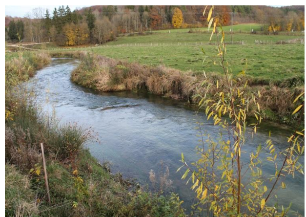
Exemple de réaménagement sur la Digeanne après travaux (Novembre 2014)
