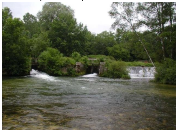
Ouvrages avant travaux (Juin 2010)
