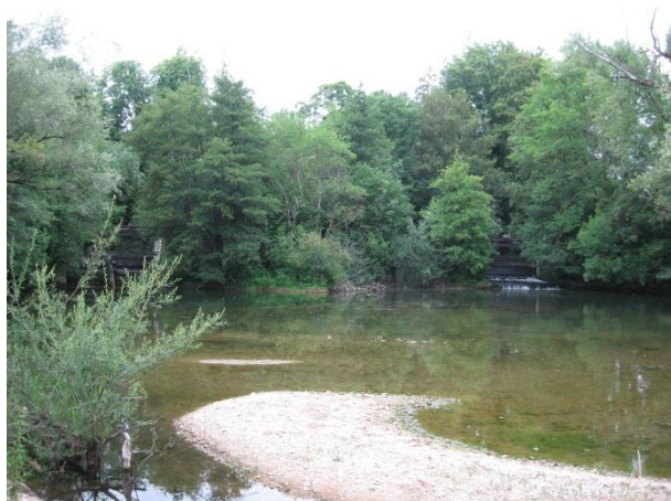
Ouvrage hydraulique (au fond à droite) avant travaux (Juillet 2011)
