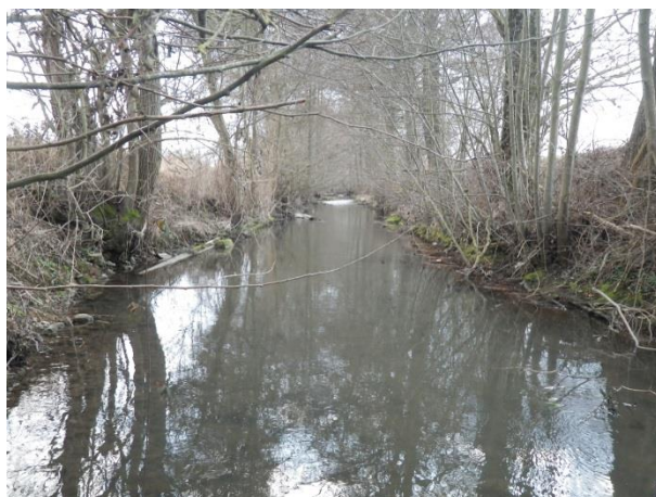
Ru du Cuivre avant travaux (Mars 2011)
