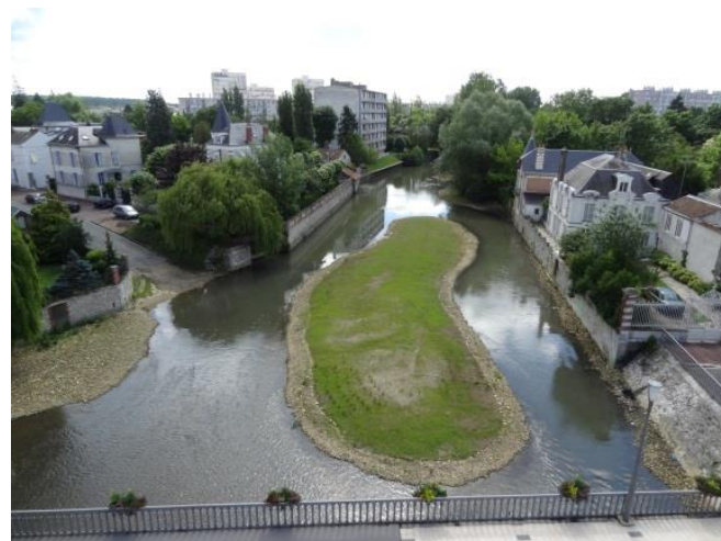
Le Loing après travaux (2012)
