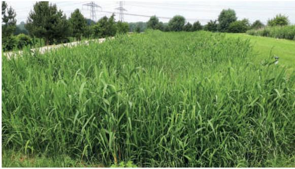
Traitement des boues sur lits de séchage plantés de roseaux - Station d'épuration de Yerville
